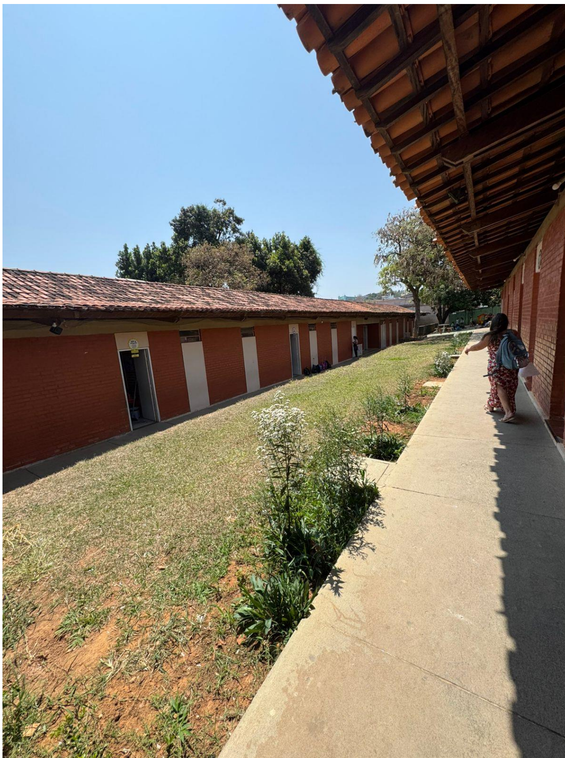
Foto 6: Telhado cerâmico a ser reformado - Bloco 01 e 02
